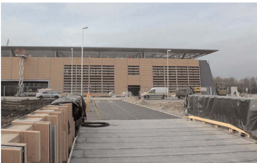
Außenansicht des Stadions
