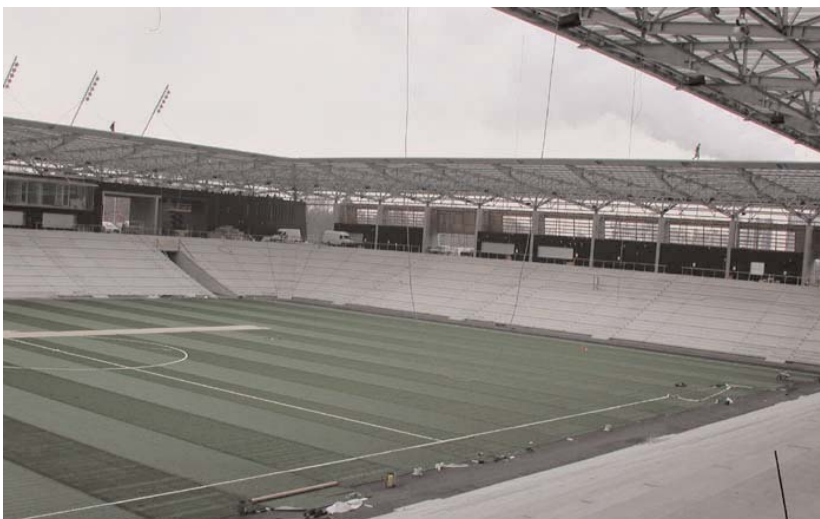
Wie diese Aufnahme vom 27. November 2002 zeigt, ist der Bau schon sehr weit fortgeschritten. Foto: Land Salzburg
