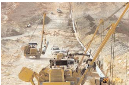
Verlegung einer 800 Kilometer langen Pipeline durch die libysche Wüste zum Mittelmeer Foto: OMV
