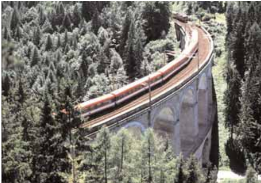
Ein InterCity-Triebwagenzug 4010 auf dem »Kalte Rinne«-Viadukt Foto: ÖBB/CI&M
