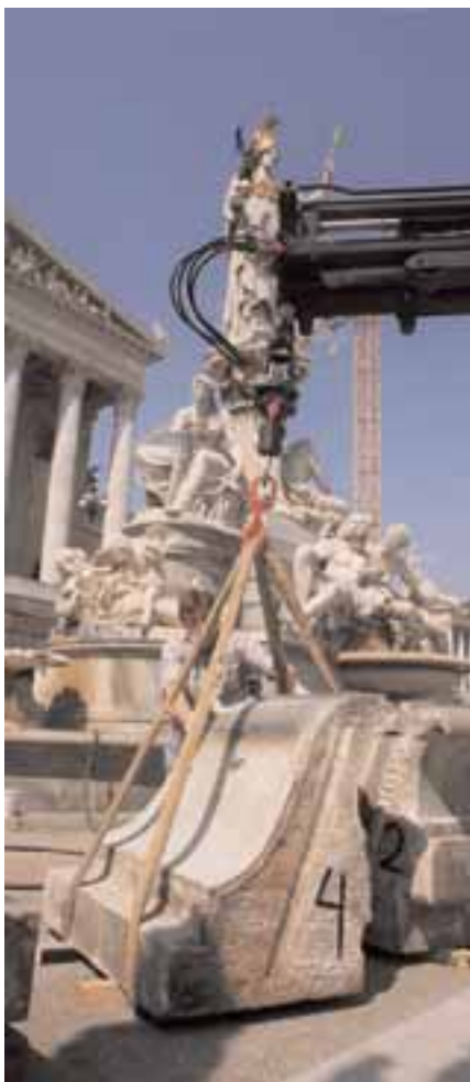
Vor dem Abbruch der Parlamentsrampe werden Einfassungen und Brüstungen Stück für Stück abgebaut ...
