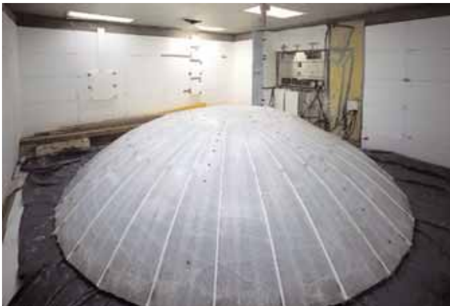
Durch Druck und Zug entsteht die Eiskuppel.
