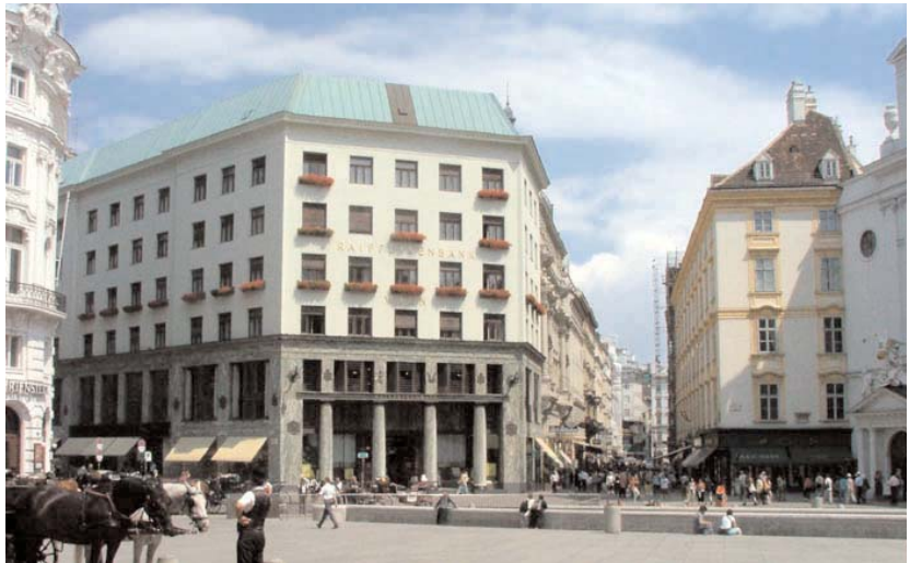
Das »Looshaus« an der Ecke zum Kohlmarkt
