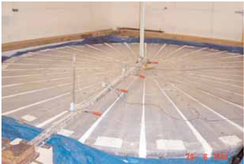
Ausgangssituation: »Eis-Scheibe«: Bei der bereits patentierten »Scheibentechnologie« entsteht grob gesprochen aus einer Scheibe eine Kuppel. Alle Fotos: TU Wien
