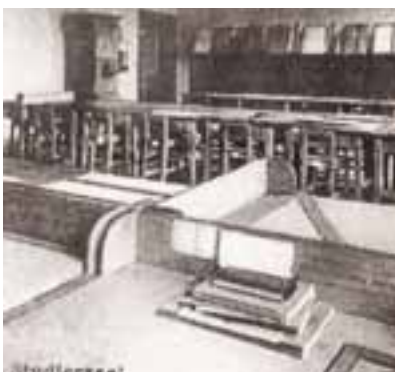
Ein Studiersaal, wie er vorerst den Militärakademikern zur Verfügung stand und schließlich lange Zeit der Bundesgewerbeschule diente Foto: Archiv HTBLuVA
