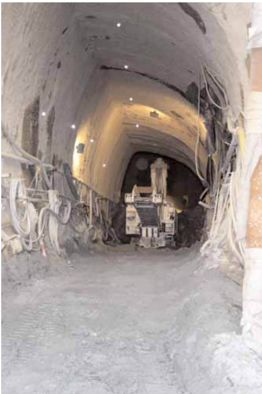
Die Tunnelröhren werden nach der Neuen Österreichischen Tunnelbaumethode hergestellt.
