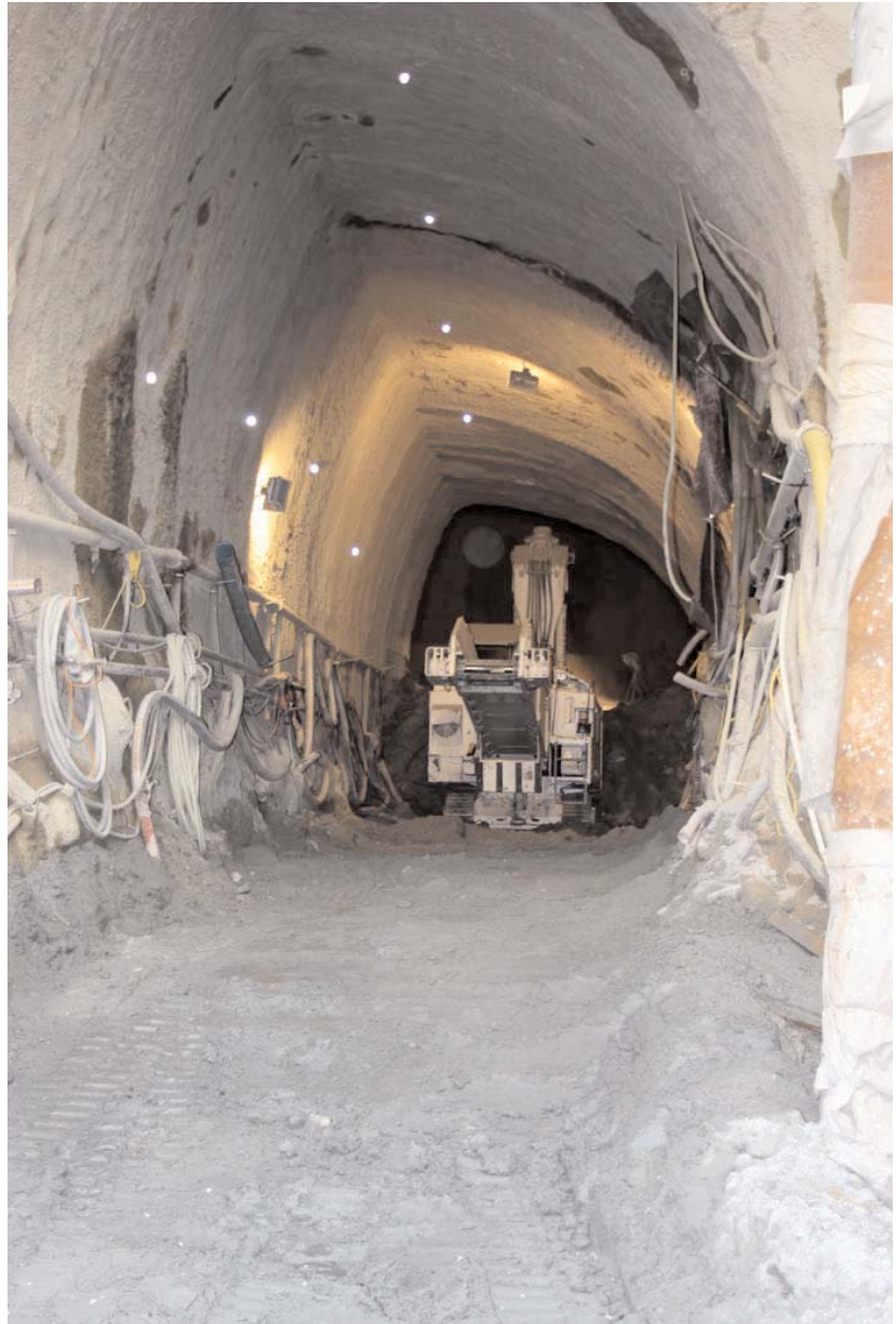
Die Tunnelröhren werden nach der Neuen Österreichischen Tunnelbaumethode hergestellt. Foto: Wiener Linien
