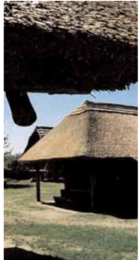
Soweit nur möglich, wurden beim Bau der Museumshäuser ausschließlich der urgeschichtlichen Zeit entsprechende Materialien und einfache Handwerkzeuge ...
