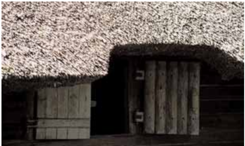
Detail der Bauweise: komplizierte Holzscharniere und dicke Schilfdeckung
