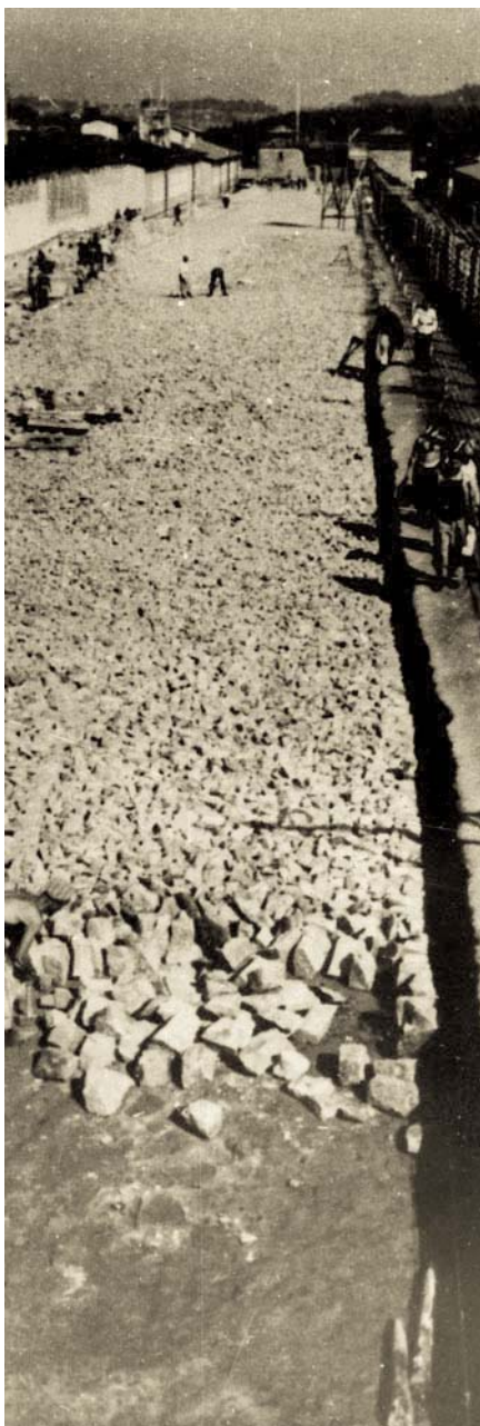
Aufbau des Appellplatzes Foto: Archiv MKÖ
