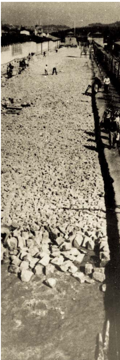
Aufbau des Appellplatzes Foto: Archiv MKÖ
