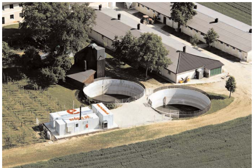
2005 ging in Pucking die erste Biogas-Anlage Österreichs in Betrieb, die gereinigtes Biogas in das Erdgas-Leitungsnetz einspeist.
