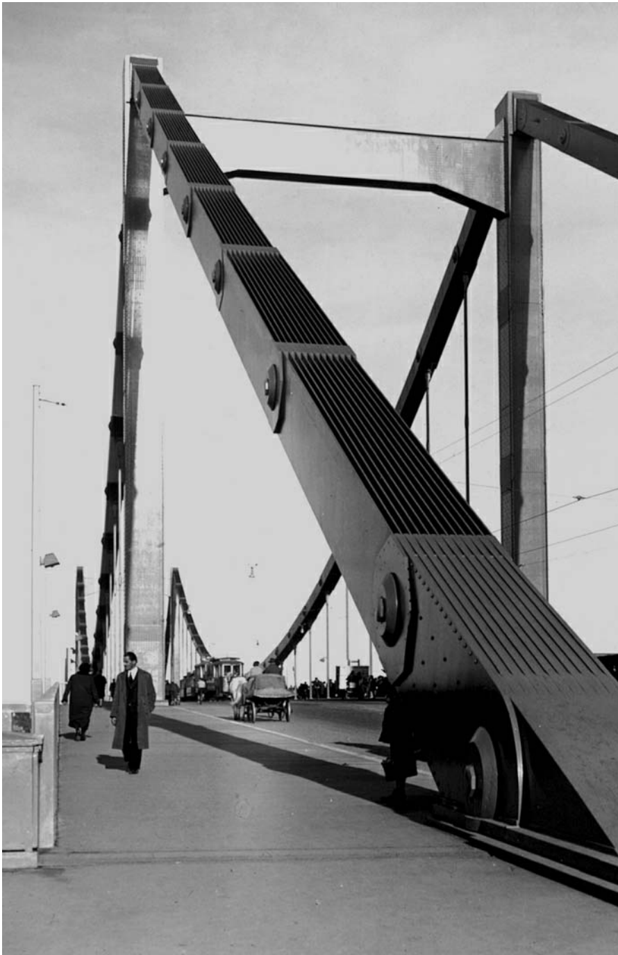
Ein Altvertrautes Bild von der Reichsbrücke, so, wie sie bis zum 1. August 1976 dem Verkehr, auch der Straßenbahn diente. Foto: MA29
