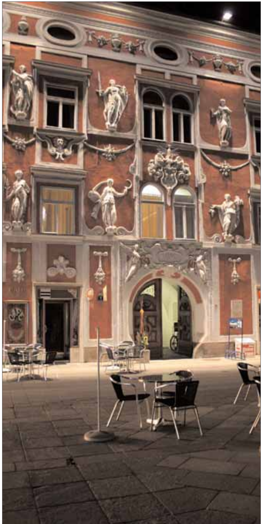
Am Hauptplatz befindet sich das wunderschöne »Hacklhaus« aus dem 16. Jahrhundert mit reich verzierter Stuck-Fassade
