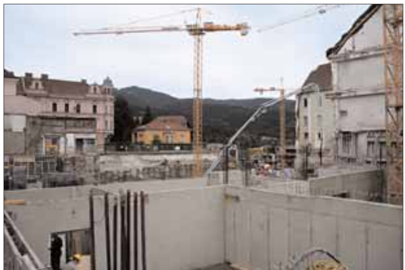
Überall wird gebaut: Leoben, die »Stadt der Kräne«
