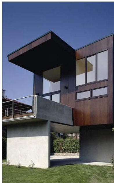
Ein 2003 errichtetes Strandhaus der Architekten DREER2 führt eine perfekte Raumoptimierung auf 35 m 2 vor.
