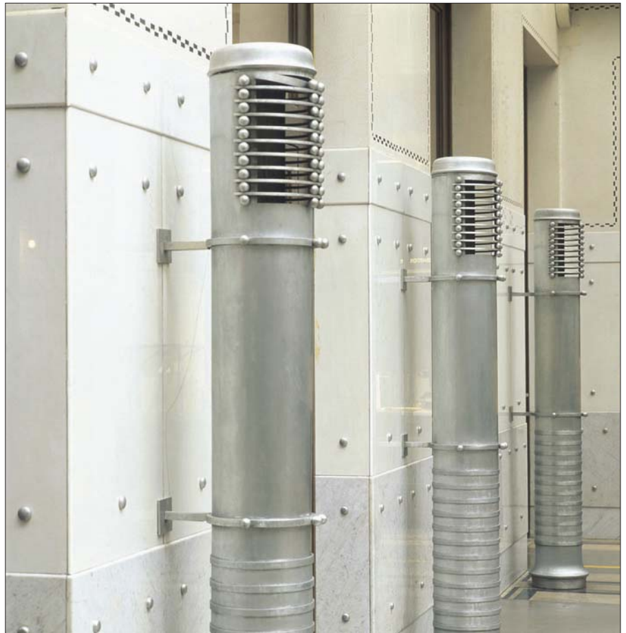
Otto Wagner – Wärmeluftausbläser im Großen Kassensaal der Österreichischen Postsparkasse
