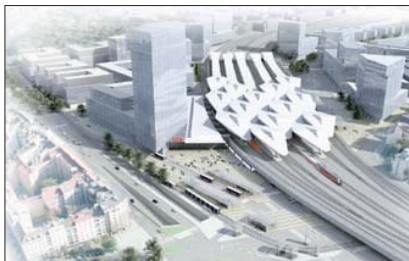
Baubeginn für Hauptbahnhof Wien S 22
