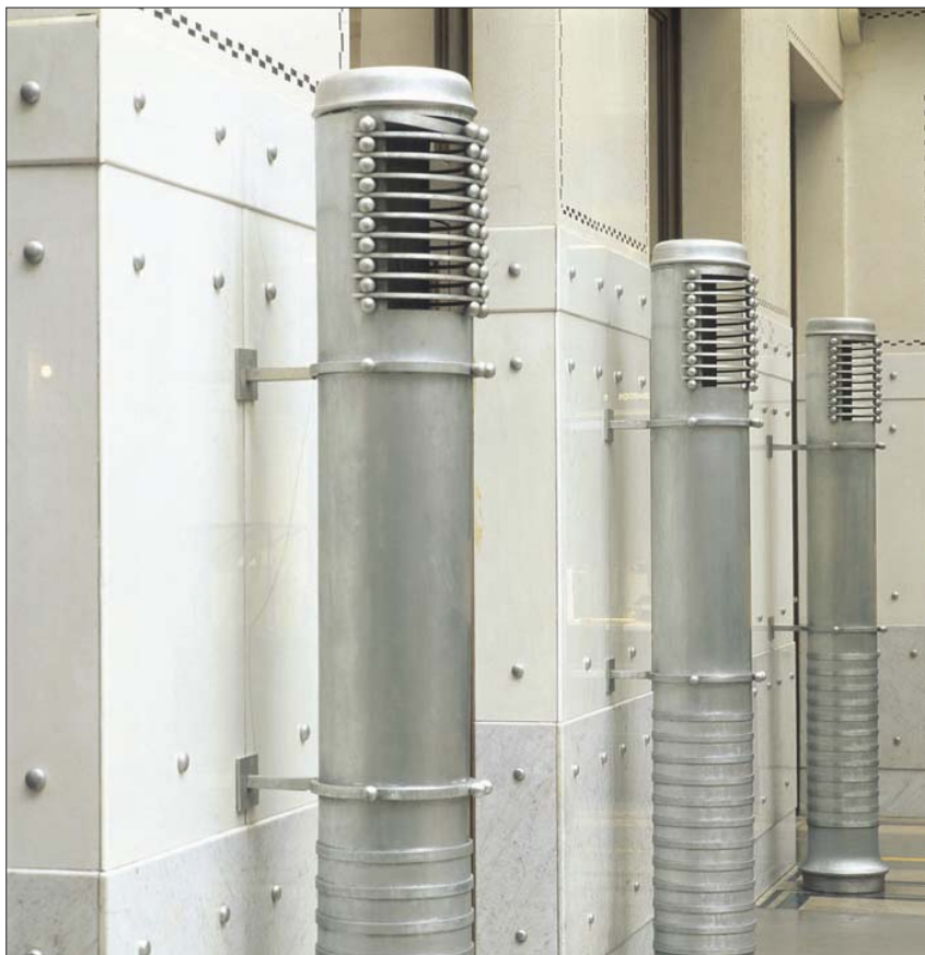
Otto Wagner – Wärmeluftausbläser im Großen Kassensaal der Österreichischen Postsparkasse
