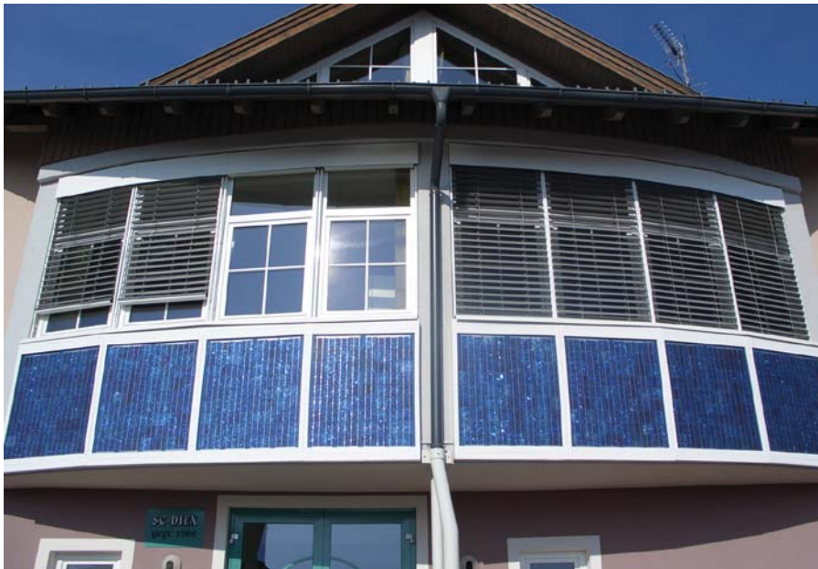
Fotos: Photovoltaik Austria
