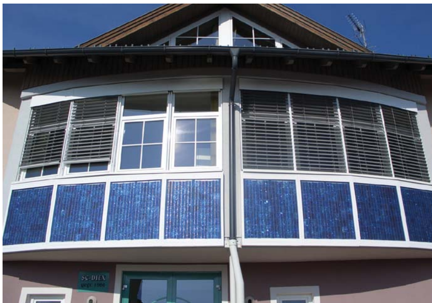
Fotos: Photovoltaik Austria
