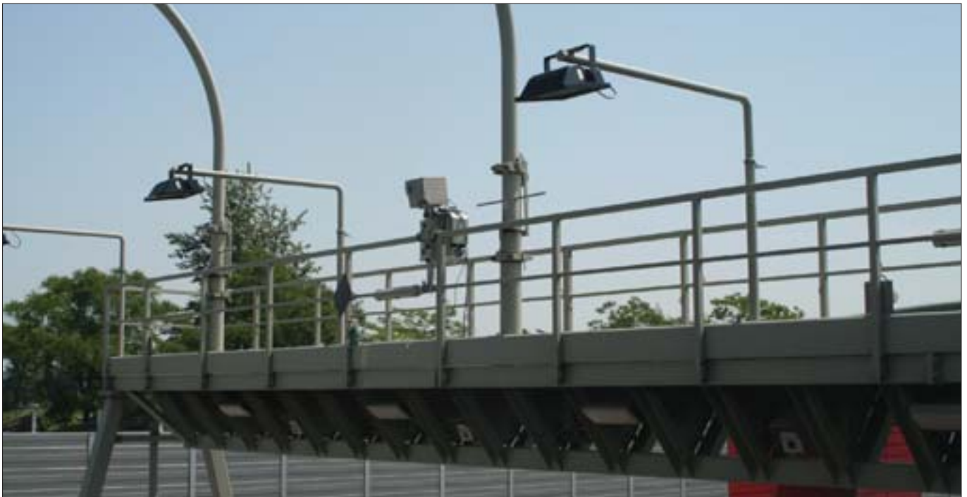
Eine Kamera mit niedriger Auflösung ermittelt das Übersichtsbild der Fahrbahn und dient der Berechnung der Geschwindigkeit des aufgenommenen Fahrzeugs. Fotos: ASFINAG
