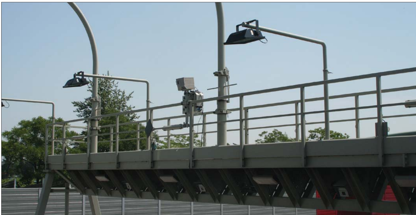
Eine Kamera mit niedriger Auflösung ermittelt das Übersichtsbild der Fahrbahn und dient der Berechnung der Geschwindigkeit des aufgenommenen Fahrzeugs.
