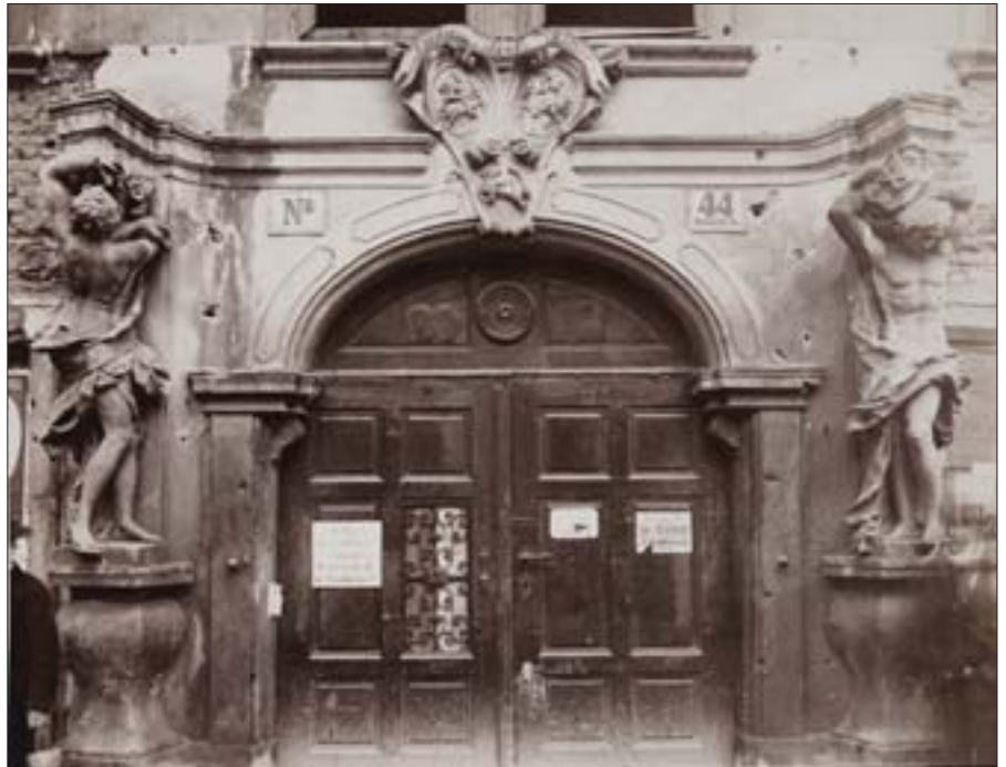
Portal Mariahilfer Straße 44, demoliert vor 1903 Foto: August Stauda, 1899
