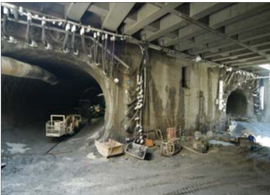
Untertunnelung für die U 6 unter dem Donaukanal
