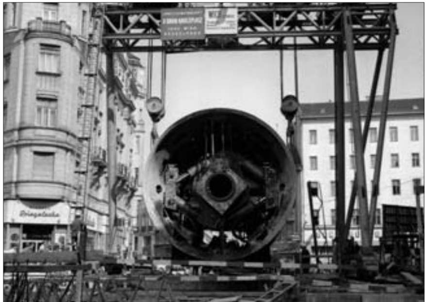
Die in Wien für den Tunnelvortrieb eingesetzte Schildmaschine – hier im vor dem Einsatz für die U 1-Verlängerung – wurde liebevoll »Wiener Maulwurf« genannt.
