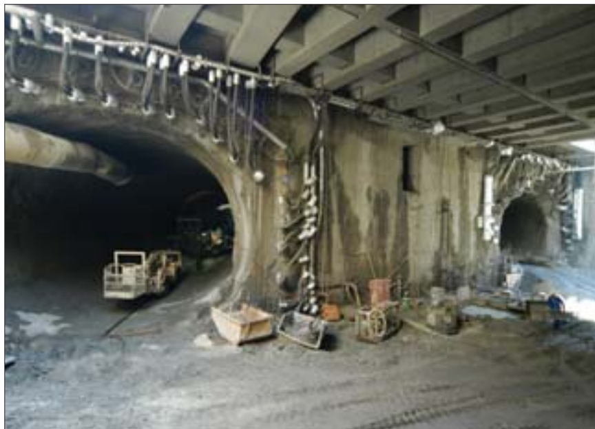
Untertunnelung für die U 6 unter dem Donaukanal
