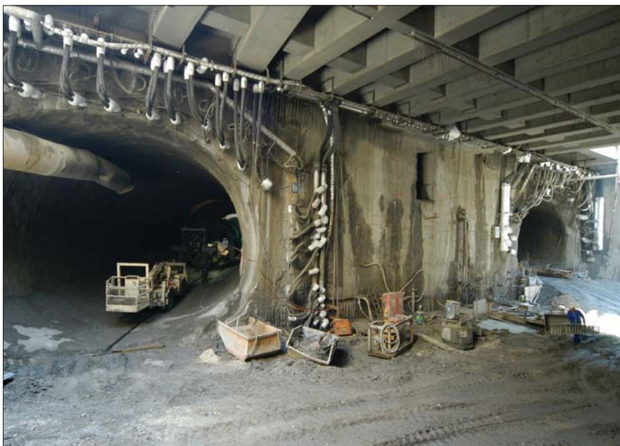
Untertunnelung für die U 6 unter dem Donaukanal
