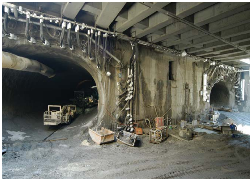
Untertunnelung für die U 6 unter dem Donaukanal
