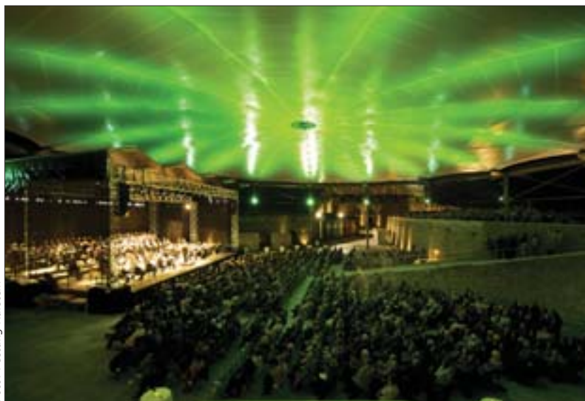
Die mobile Überdachung der Festungsarena sorgt bei jedem Wetter für trockenen Kulturgenuß.
