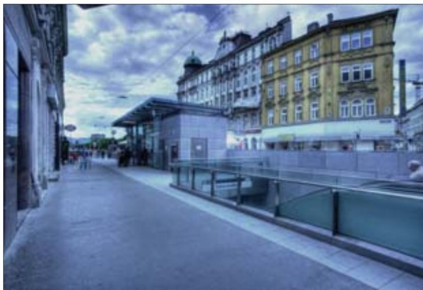
»Station Taborstraße« mit Blick Richtung Obere Augartenstraße – »ebenerdig« ...
