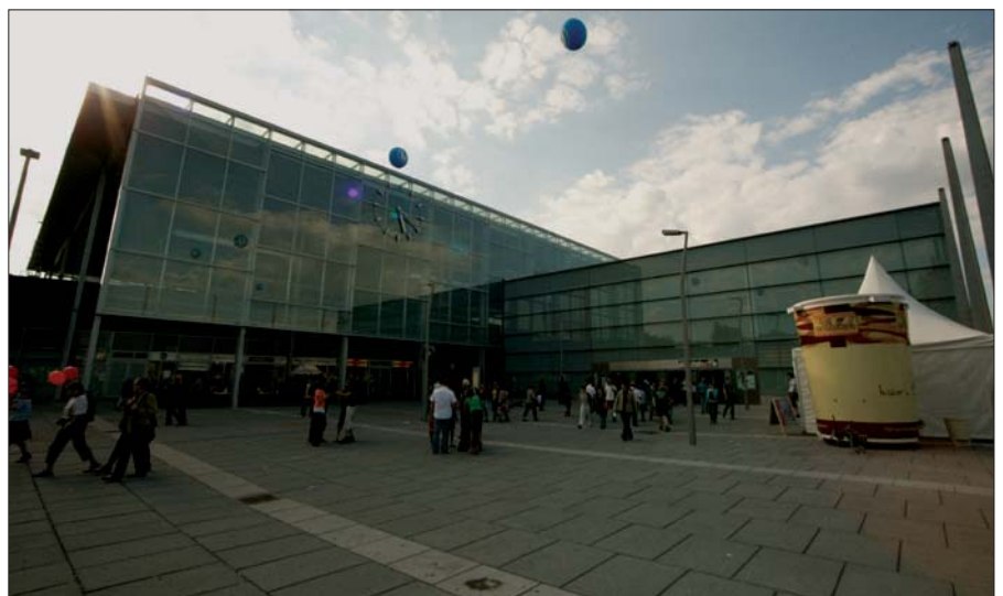
... darüber der erst vor kurzem fertiggestellte »Bahnhof Praterstern«
