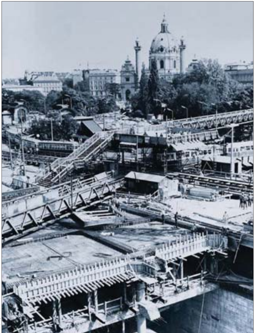
1971 die größte Baustelle Europas: der U-Bahn-Bau am Karlsplatz
