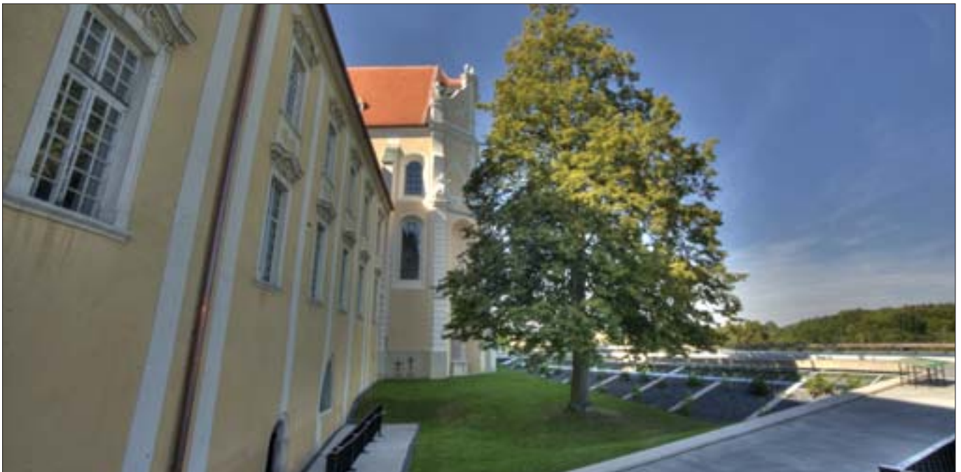
Im Zusammenhang mit der statischen Sanierung der Altane, der »barocken Aussichtsterrasse hoch über dem Kamp«, wurde zwischen 2001 und 2006 der mittelalterliche Außenbezirk des Klosters freigelegt und überdacht.
