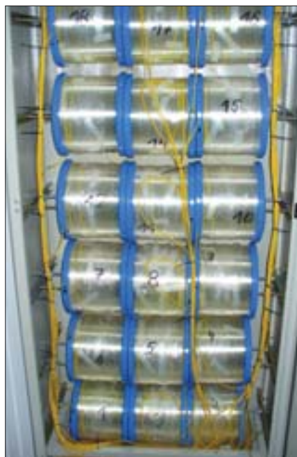
1000 km optische Glasfaser im Institut für Breitbandkommunikation
