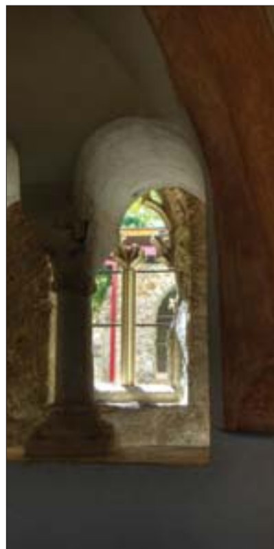
Ein romanisches Fenster im Kapitelsaal, der an den Kreuzgang anschließt
