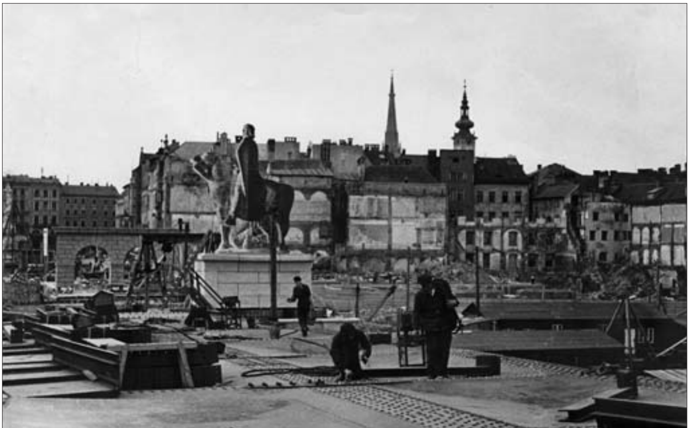
Abbrucharbeiten im Zuge des Neubaus der Nibelungenbrücke Ende 1940
