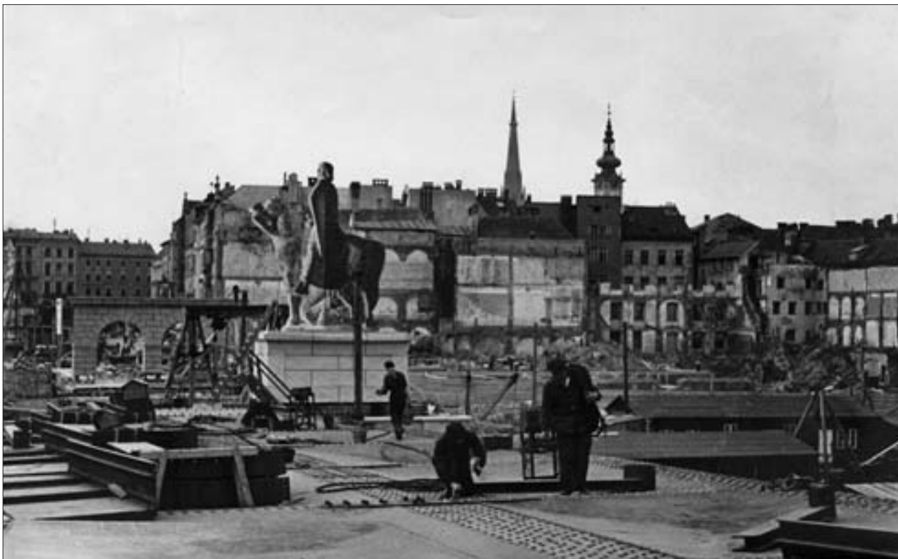
Abbrucharbeiten im Zuge des Neubaus der Nibelungenbrücke Ende 1940
