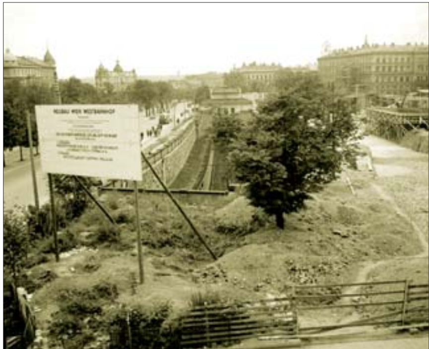
Ein Bild aus 1950, als der Wiener Westbahnhof gebaut wurde
