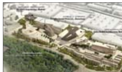
Neubau der WU Wien S 54
