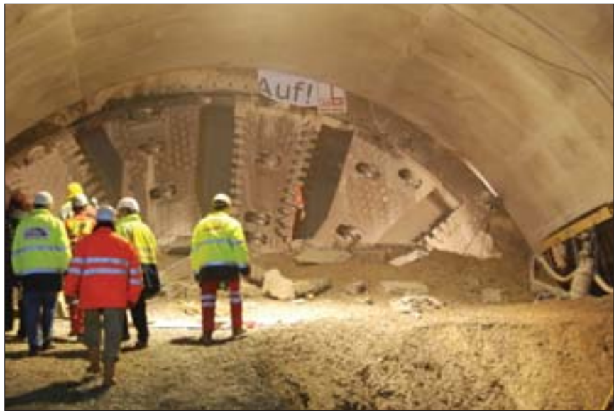
Der Durchstich der Tunnelvortriebsmaschine geglückt!
