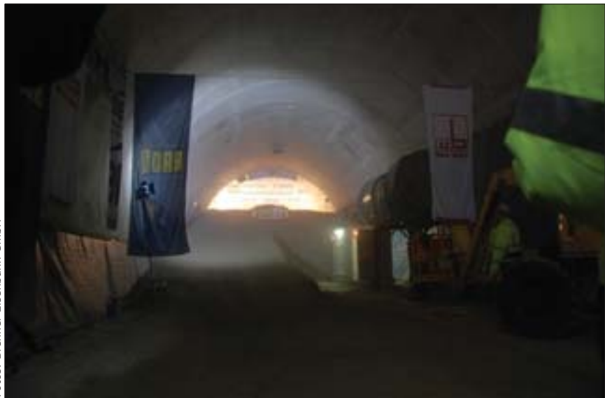
Einfahrtskaverne im Los H3-6
