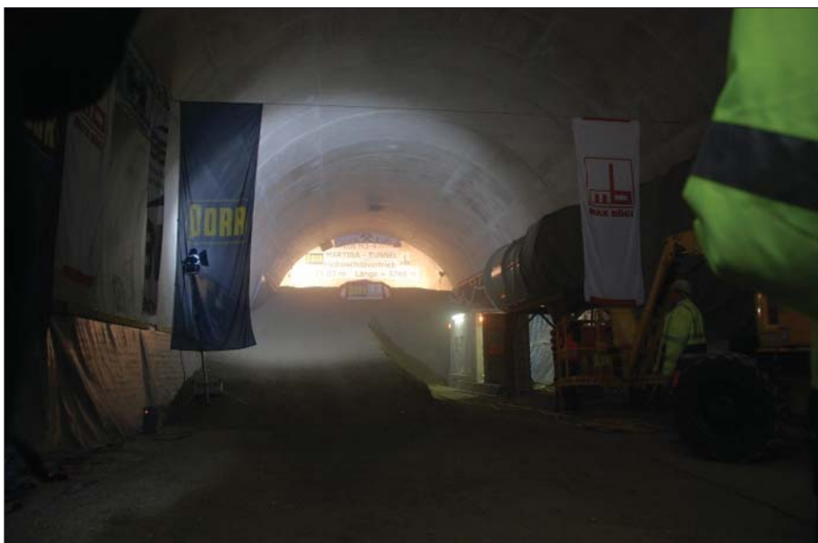
Einfahrtskaverne im Los H3-6
