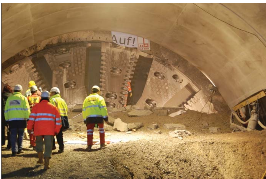
Der Durchstich der Tunnelvortriebsmaschine geglückt!
