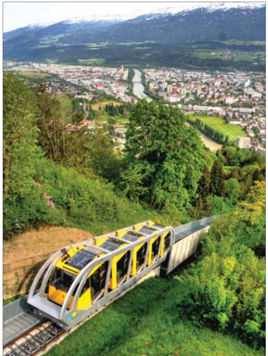
... auch bei der »Hungerburgbahn neu« haben die Planer und Ingenieure alles an letztem Stand der Technik in die Umsetzung einfließen lassen.
