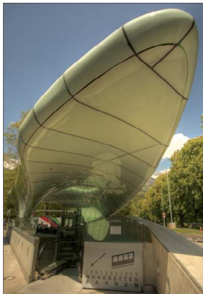
Talstation der neuen Hungerburgbahn
