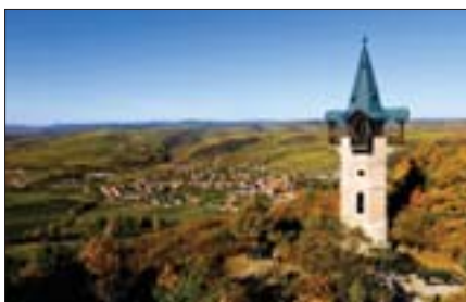
Langenlois in neuem Gewand
