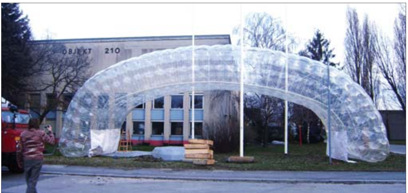
Die Zukunft gehört Elementen von ca. 6 m Kantenlänge – denn pneumocell soll schon bald nicht nur für kleinere Bauobjekte, sondern auch für Hochbaukonstruktionen mit 30 m oder mehr Spannweite nutzbar sein.
