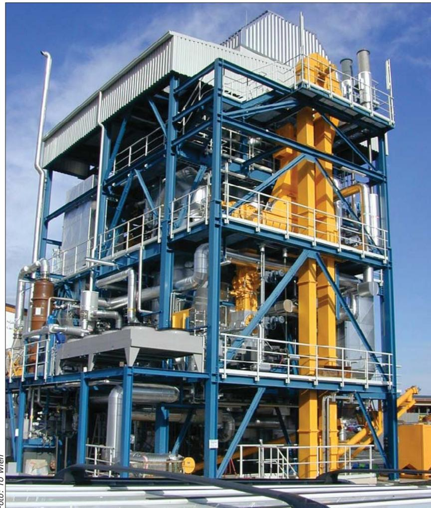
In den burgenländischen Gemeinden Güssing und Oberwart stehen Pilotanlagen für völlig neuartige Zwitter aus Kraftwerk und chemischer Fabrik.
