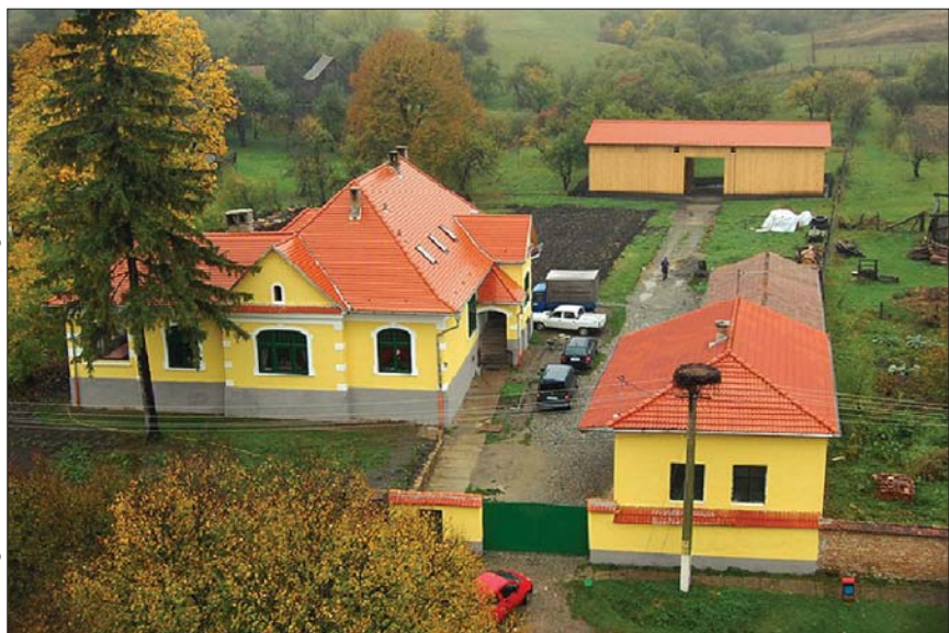
Nach nachhaltigen Restaurierungs- und Renovierungsarbeiten entstand aus dem Repräsentativgebäude des Pfarrhofs ein Bildungs- und Begegnungszentrum.
