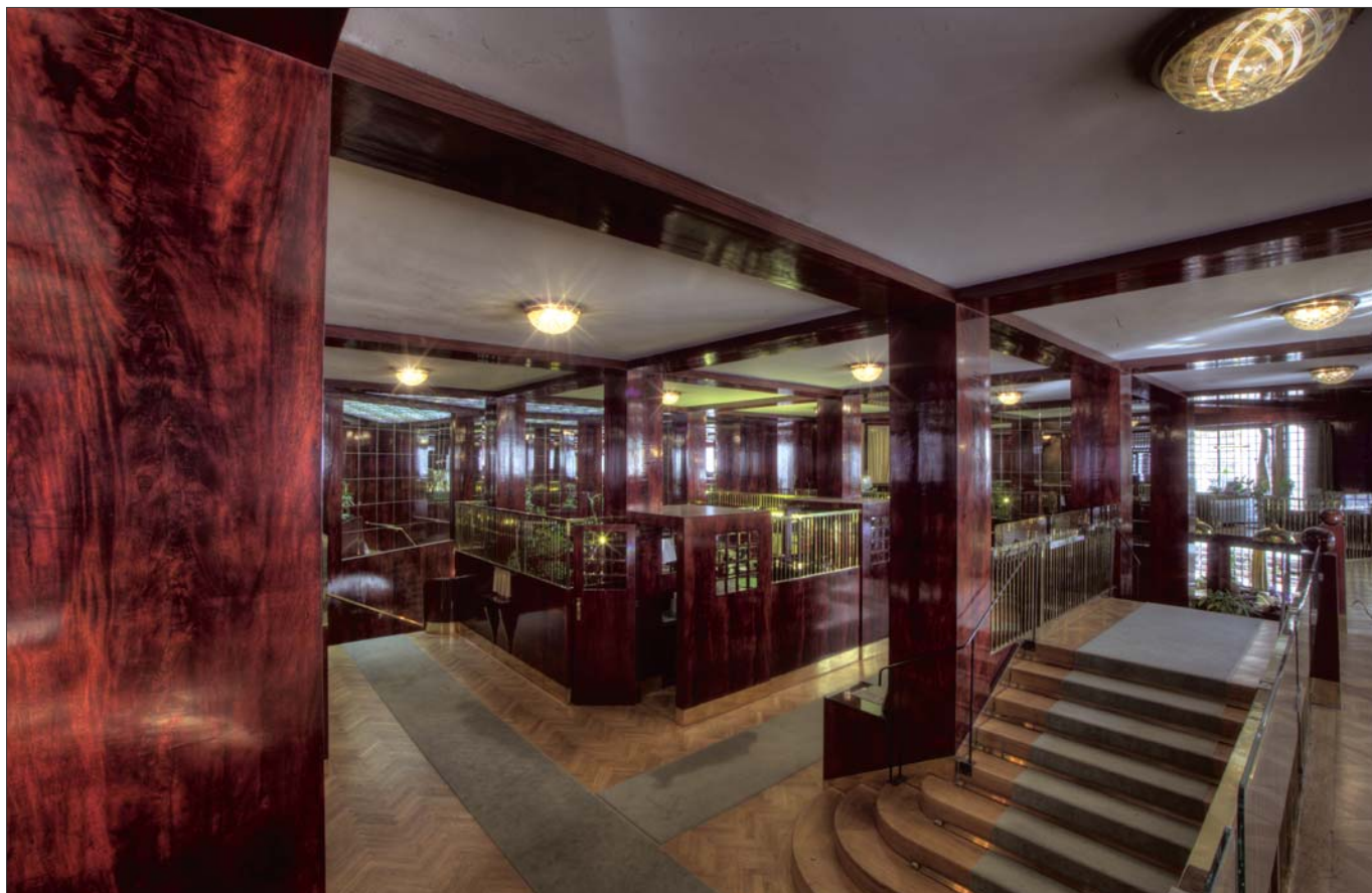
Das lichtdurchflutete Mezzanin beherbergte früher Buchhaltung und Kassa. Die Pfeiler und Deckenunterzüge sind mit Mahagoni verkleidet, die edlen Parkettböden auf den »Gehwegen« von Läufern geschützt.
