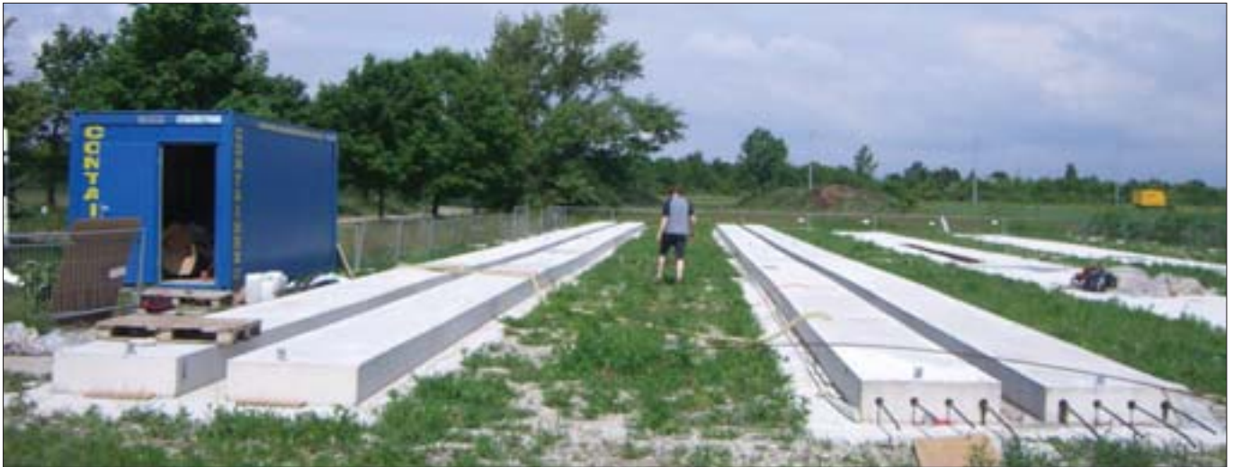
Großversuche an 60m langen Plattenstreifen auf dem Flugfeld in Aspern, Wien
