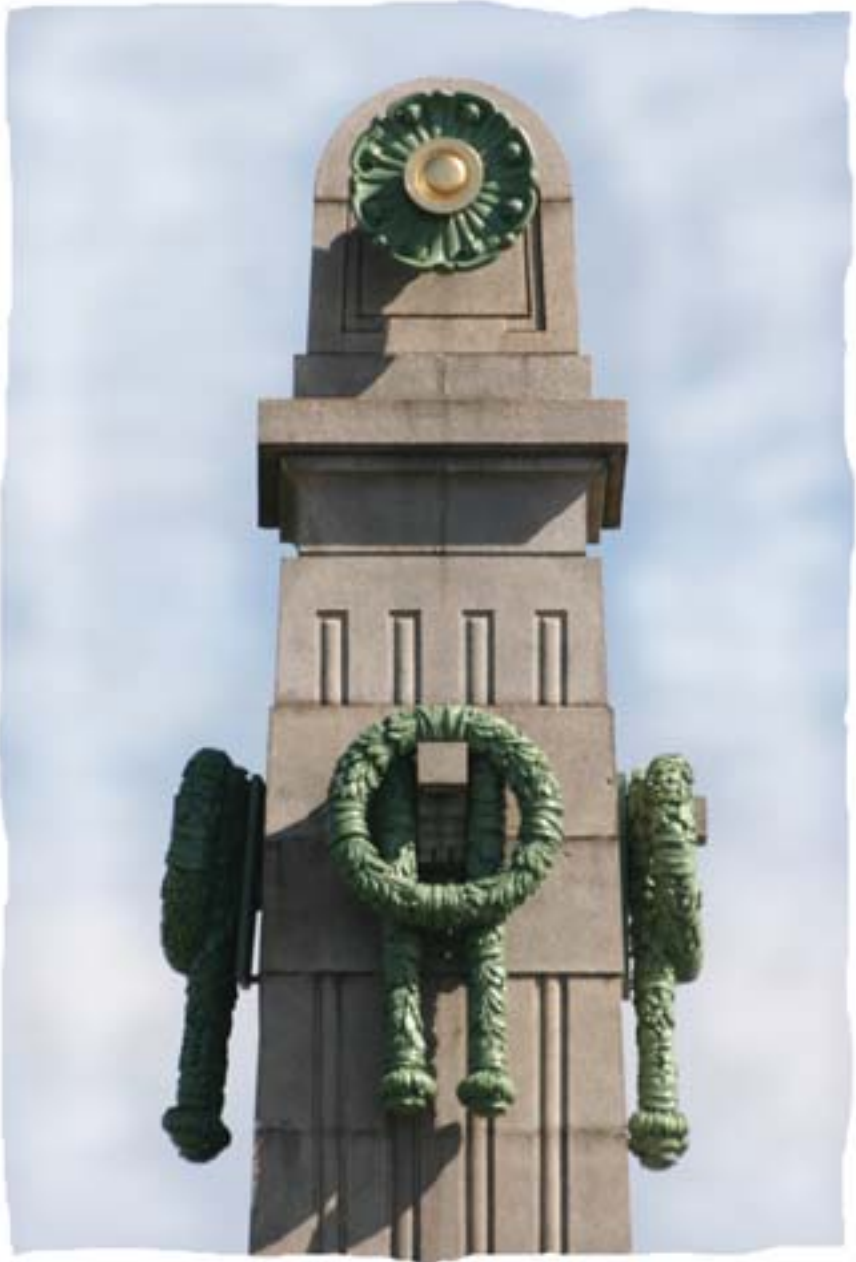
Otto Wagners »Autogramm«... Wien 15, Stadtbahn-Brücke über die Zeile (U-Bahnbrücke über das Wiental) 1895-1898
