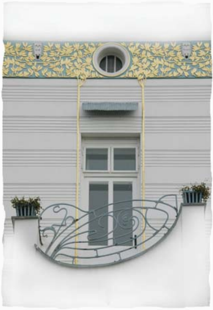
Versteckt aber exquisit: Reihenhausanlage in Brunn am Gebirge (NÖ) von Sepp Hubatsch 1902-12
