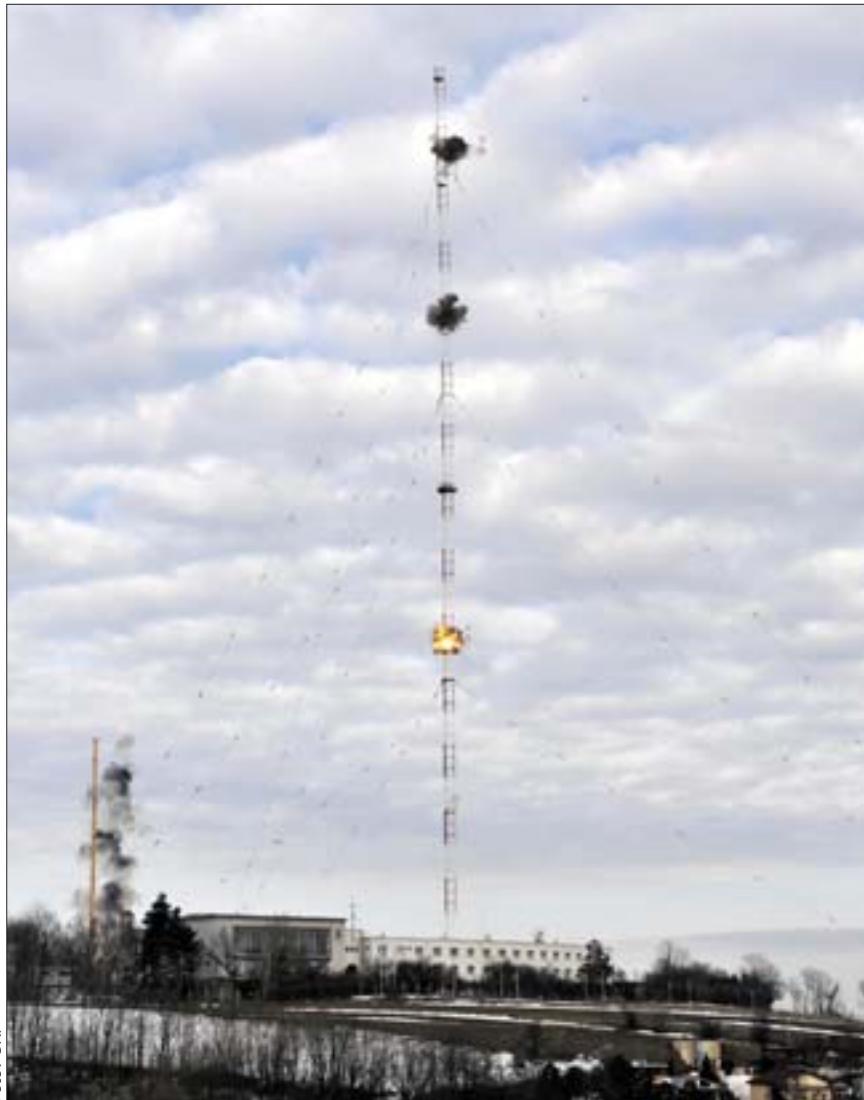
Gezielte Sprengung des großen Sendemasten am Bisamberg
