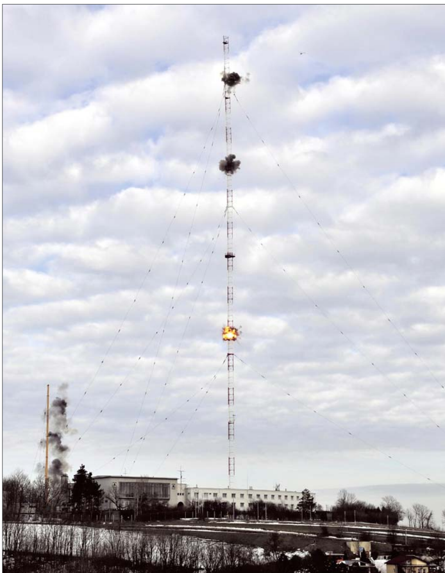
Gezielte Sprengung des großen Sendemasten am Bisamberg
