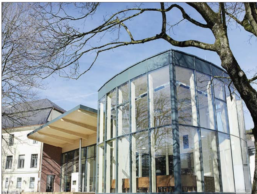
Um mehr als 1,5 Millionen Euro wurde ein neues Brauhaus in Zipf errichtet.
