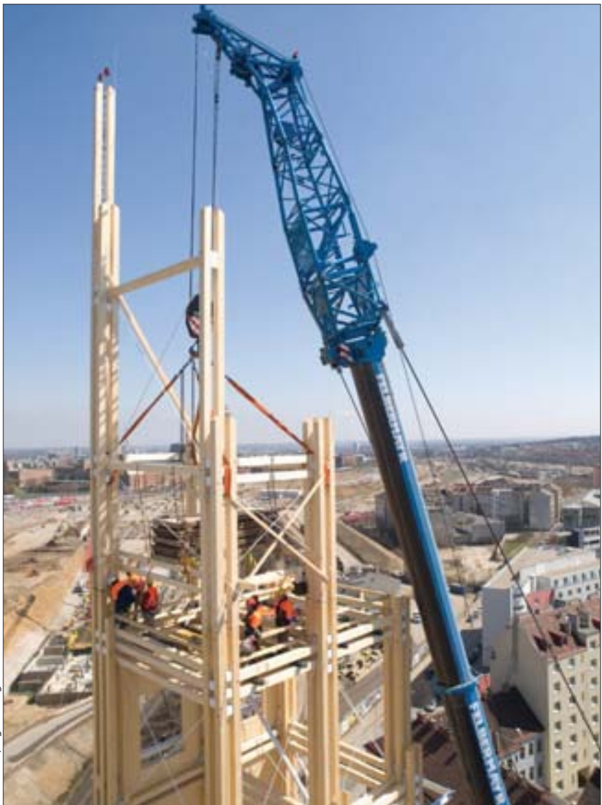
Bild rechts: In vier »Schüssen« wurden die vier vor Ort vorgefertigten Module von jeweils 15 Metern hochgehoben und montiert. Die Module wurden nacheinander auf den Sockel aus Stahl gesetzt und mit Konstruktionsschrauben verbunden.
