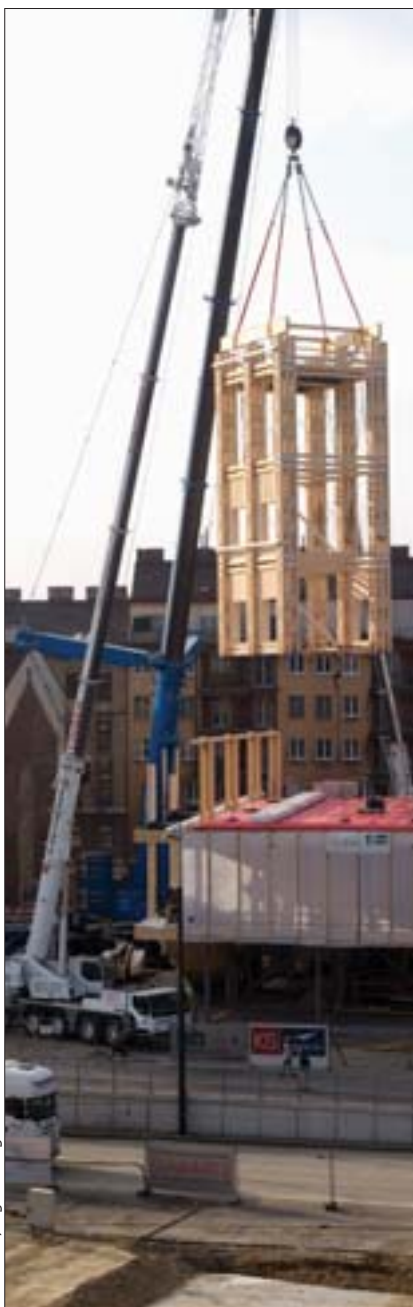
135 Tonnen wiegt die gesamte Konstruktion des Aussichtsturms.
