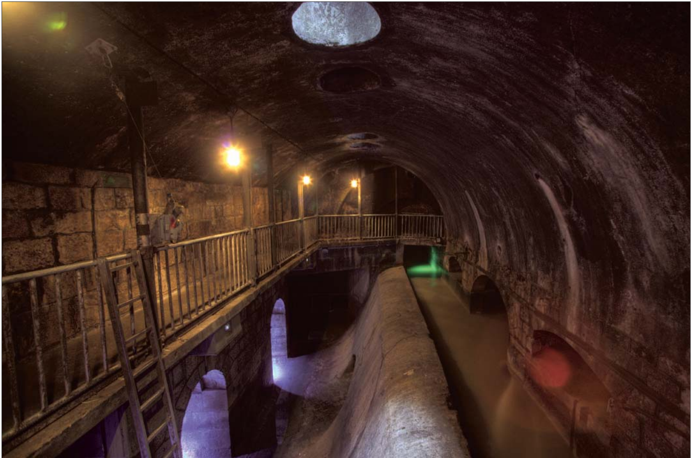
Besonders eindrucksvoll sind die Bauwerke des Linken-Wienfluß-Sammelkanals und des Ottakringer Bachs.
