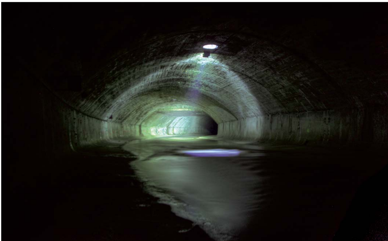
Eine einmalige »unterirdische« Aussicht bietet der Abschluß der Führung – in den Wienfluß. Dieser verschwindet unter dem Naschmarkt in einem gewaltigen Gewölbe, dessen Dimension mit Scheinwerfern eindrucksvoll in Szene gesetzt wird.
