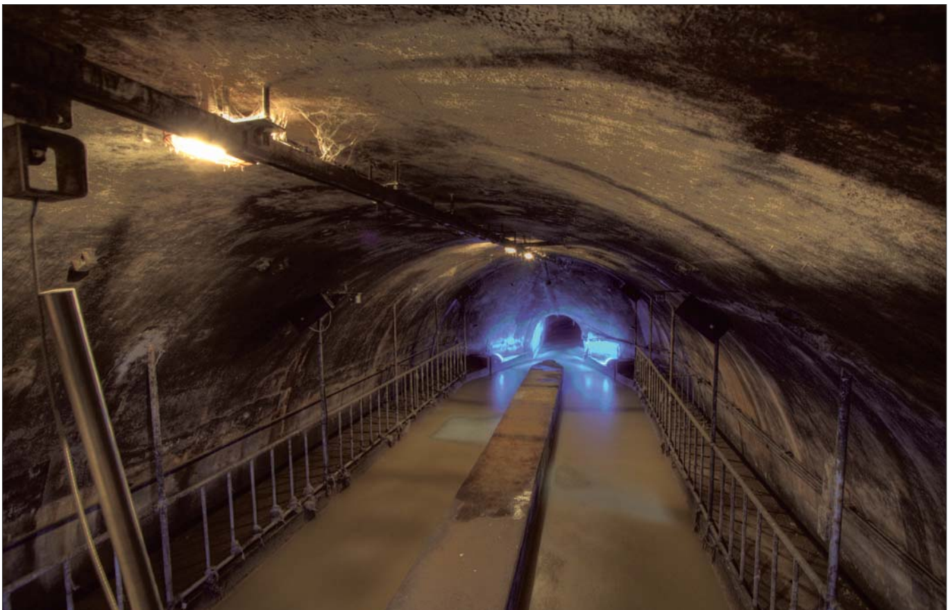
Die beiden Wienflußsammelkanäle sind die ältesten Sammelkanäle Wiens und die bedeutendsten Zubringer des Rechten Hauptsammelkanals. Bereits bei geringen Niederschlagsmengen sprangen die Regenüberläufe der Wienfluss Sammelkanäle an und leiteten Mischwasser in den Wienfluß. Durch den Wiental-Kanal ist dieses Ableiten nicht mehr notwendig.
