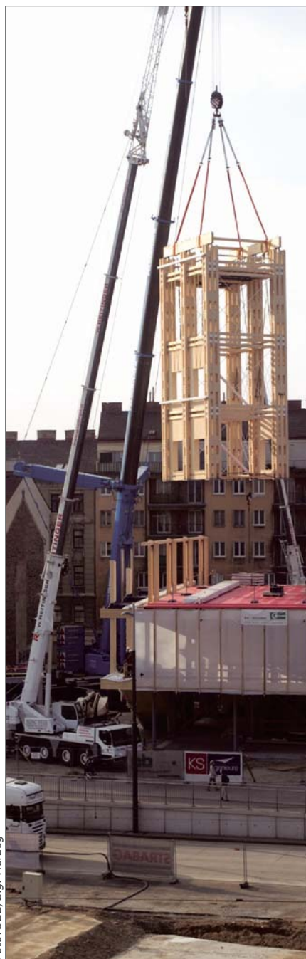
135 Tonnen wiegt die gesamte Konstruktion des Aussichtsturms.
